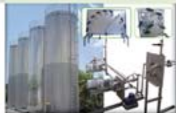
BATTERIES DE BACS DE STOCKAGE ISOTHERMES POUR SUCRE LIQUIDE
